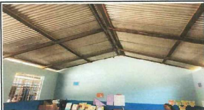
Foto 3: Se puede observar que la estructura del techo se necesita cambiar del modulo 2 de 4 aulas.
